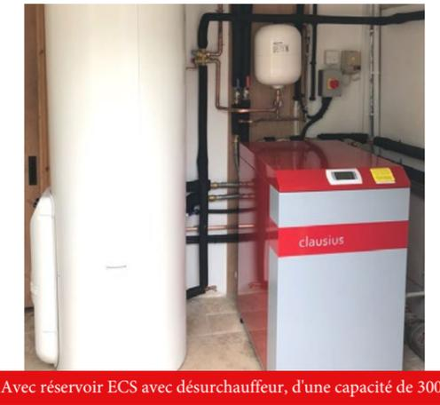
Avec réservoir ECS avec désurchauffeur, d'une capacité de 300 l
