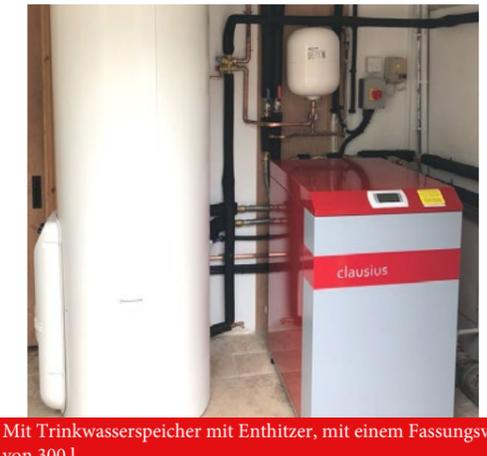
Mit Trinkwasserspeicher mit Enthitzer, mit einem Fassungsvermögen von 300 l
